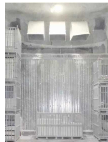
上吸い下吹き型の冷却器 (冷蔵庫上部)
